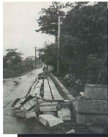
■ 県内各地で門柱やブロック塀が倒れ、痛ましい犠牲者を出した。
