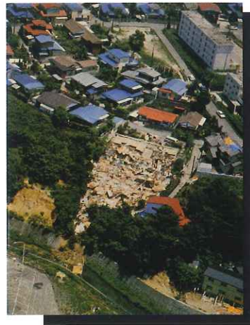
■ 倒壊したアパート(市内北根字一念坊)
