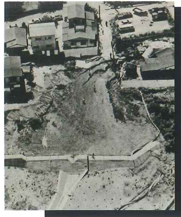
■ 広い範囲にわたってずれた地盤(市内 緑ヶ丘)
