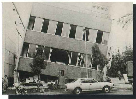
■ 1階が完全に潰れ傾くビル(市内 卸町・苦竹)
