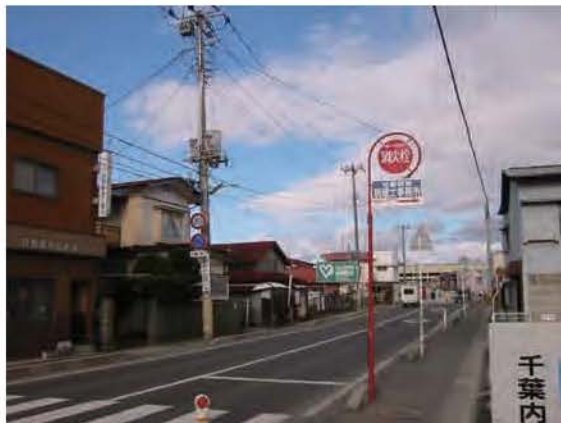
トランスと消火栓
