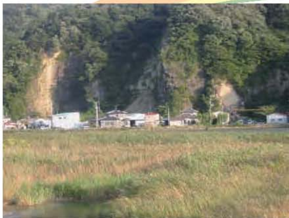
急傾斜地の崖崩れ↑ 右写真は直近の崩壊状況→
