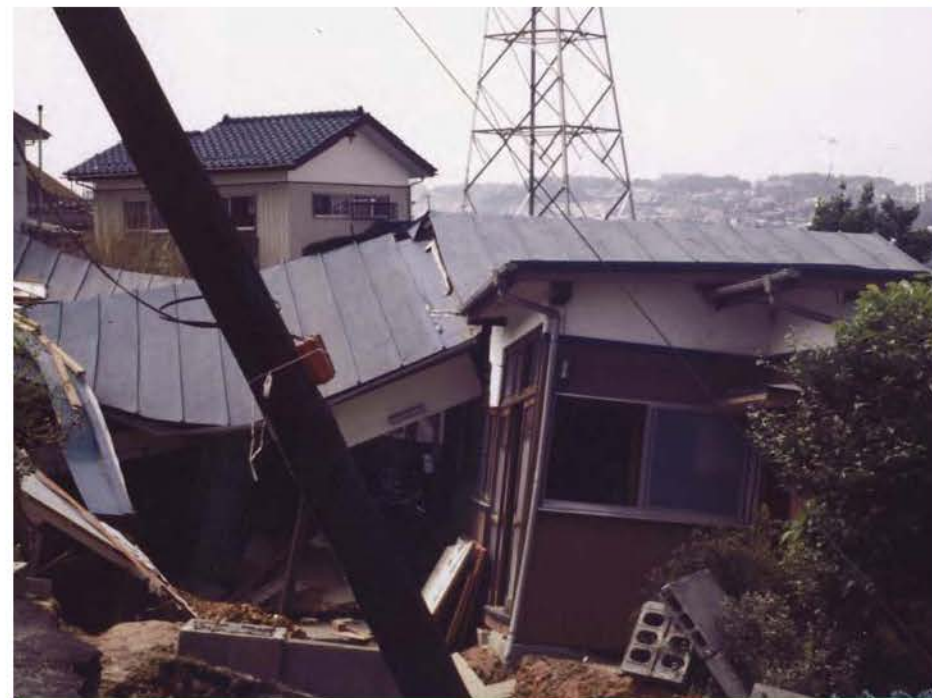
1978年6月12日 宮城県沖地震の建物被害
