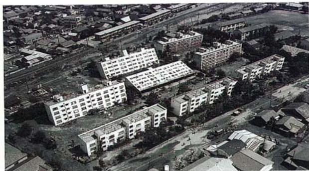
図 2.40 1964 年新潟地震による液状化と鉄筋コンクリートのアパートの傾斜と沈下
