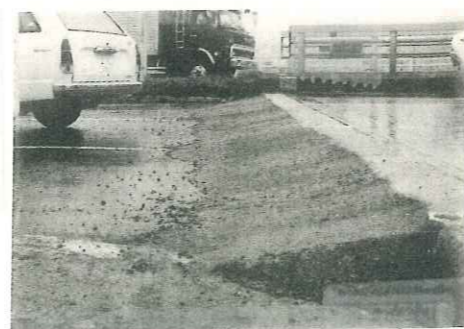
橋台の沈下(修復後の状況)
